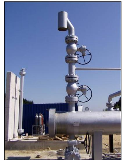
Als MSS wird eine Sendeschleuse, als MSE die Empfangsschleuse bezeichnet. Kombinierte Schleusen sind als MSS/MSE angeführt. Wie bereits beschrieben, können für jeden Molchtyp die geeigneten Schleusenlängen sowohl für die Sende- als auch für die Empfangsschleuse geliefert werden.
